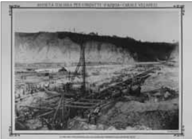
26 Aprile 1882 - Costruzione della diga alla Rapida del Panperduto, dalla destra del Ticino
