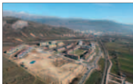
Il cantiere di Bazzano
