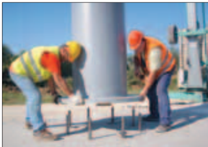
Posa dei pilastri metallici
