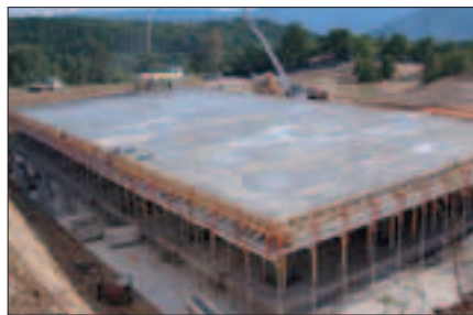
Sottostruttura pronta per realizzare l'edificio
