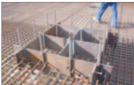
Predisposizione per l'ancoraggio dei pilastri in fondazione
