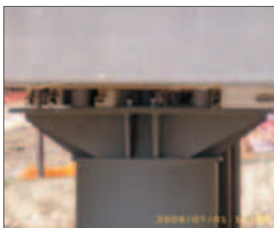
Esempio di appoggio temporaneo e fasi di sostituzione mediante sollevamento
