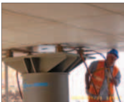
Esempio di appoggio temporaneo e fasi di sostituzione mediante sollevamento
