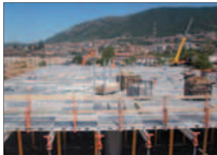
Fase di cassetteratura
